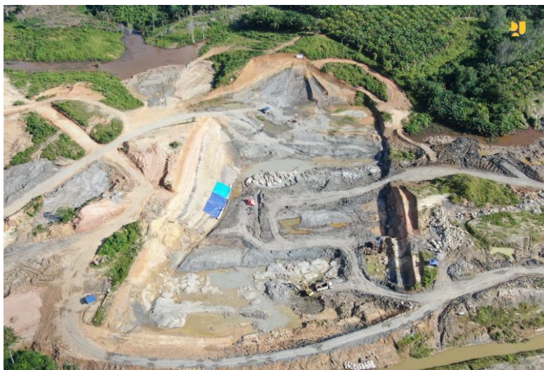
Přehrada Sepaku-Semoi je budována na dávno odlesněném území. Source : GenPI.co
